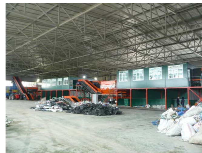
Мусоросортировочный комплекс производительностью 200 тыс. тонн ТКО в год
